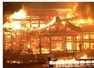
【R1.10月 沖縄県首里城火災 (那覇市消防局提供写真)】
